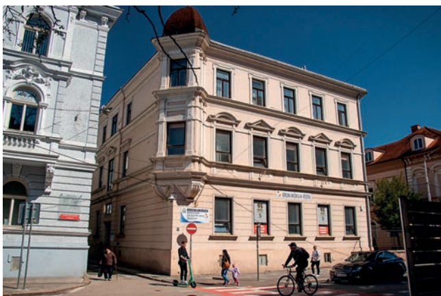
Budovu na Hasičskej ulici čaká komplexná rekonštrukcia. Zdroj: archív VKMR
