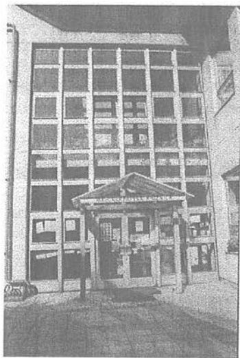
Pohľad na vstup do knižnice po jej rekonštrukcii
